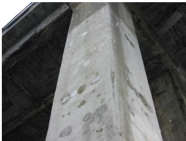
10年後の 脱塩橋脚
