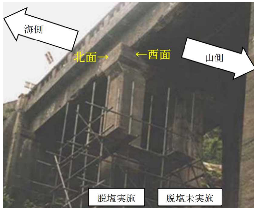
脱塩工法適用対象RC橋脚
