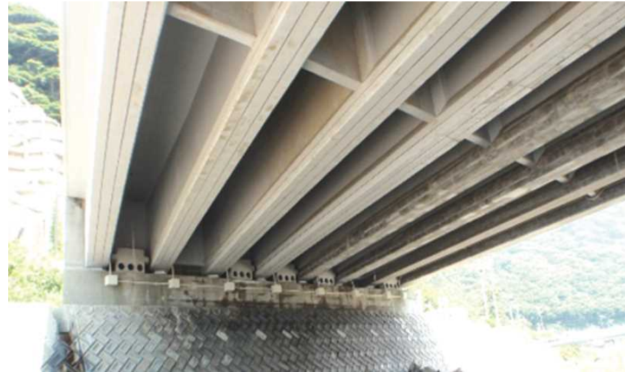
チタングリッド方式【外部電源方式】
