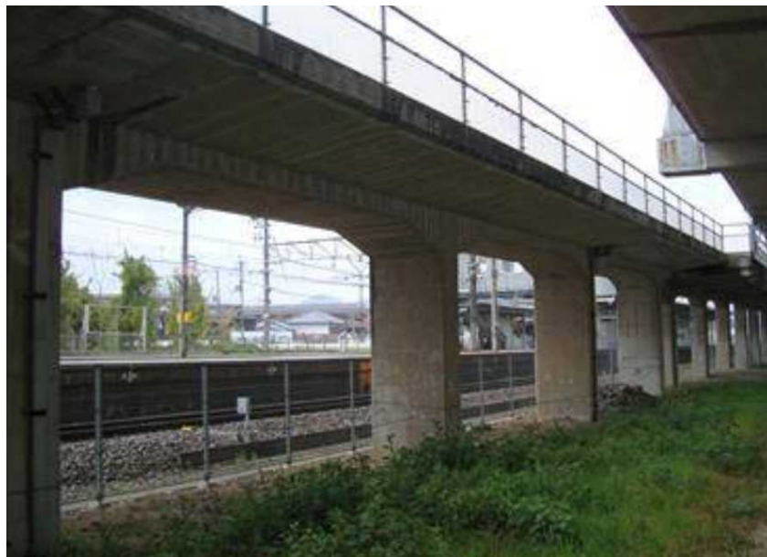
脱塩・再アルカリ化工法適用構造物
