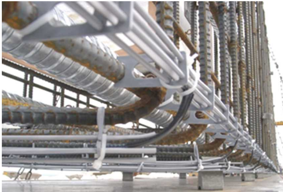
コンクリート打込み前に設置された陽極材
