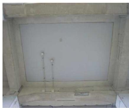
亜鉛アルミ擬合金溶射
